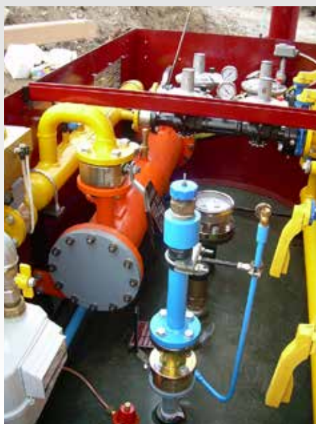
Capacity up to 300 kg/h metering line with by-pass Soluzione fino a 300 kg/h con linea di misura e by-pass
