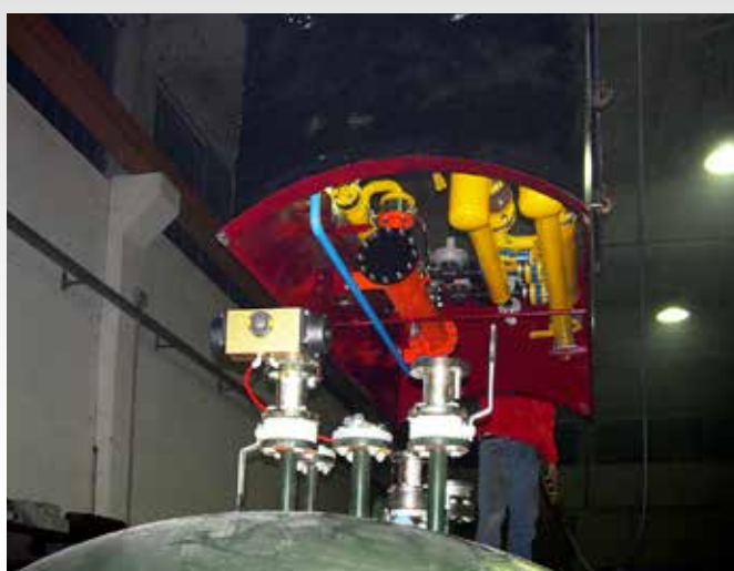
Vaporeg underground installation on tank Fase di installazione di vaporeg underground su serbatoio
