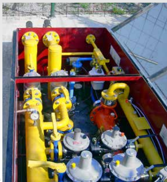
Capacity up to 300 kg/h metering line with by-pass Soluzione fino a 300 kg/h con linea di misura e by-pass
