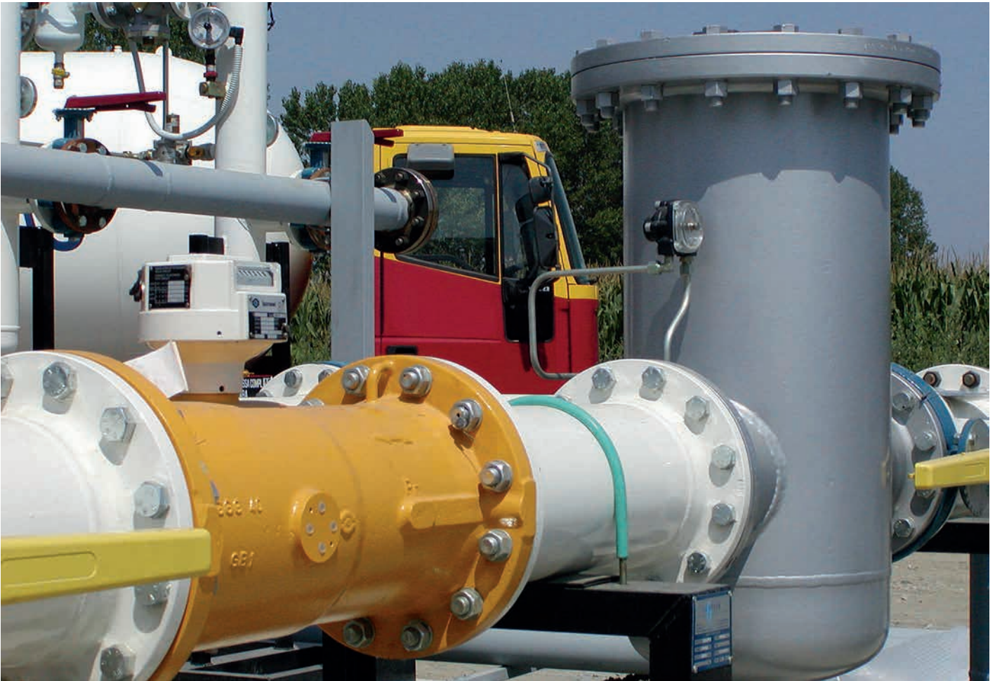
Filtering system DN200 for regulating and metering unit with capacity of 6000Kg/h. with clogging indicator. Sistema di filtrazione DN200 per gruppo di regolazione misura da 6000 kg/h. con indicatore di intasamento.
